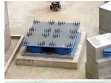
Grupo de cuatro aisladores están ubicados debajo las columnas con mucha carga en el Centro Medico Tan Tzu.
